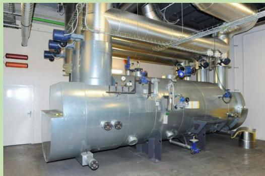
通常のだどのガス化炉の最適な水分濃度は 5%～10%程度です。このレベルの水分濃度の常時維持は、**乾燥機無しでは不可能**です。ガス化炉の故障原因の多くは、原料水分量の過多（不十分な乾燥）、水分変動によるものです。その点、本ガス化装置は標準で**乾燥機も付帯設備**に組み込まれ、**排熱利用の為、乾燥機用燃料も不要**ですので、安心です。かつ**排熱回収熱**で、湿ったチップ（仕様は最大 40%～50%程度ですが、補助熱源を使えば 60%+迄対応可の見込です。
